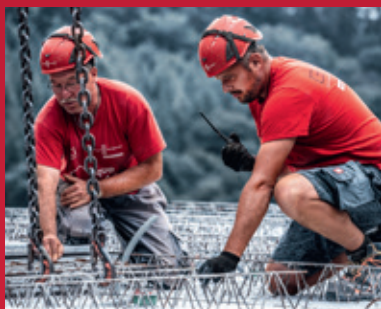
4. Verlegen der oberen Deckenbewehrung
