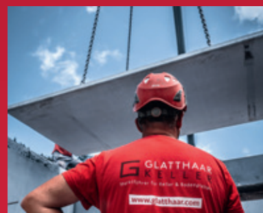
3. Verlegen der Filigrandecke
