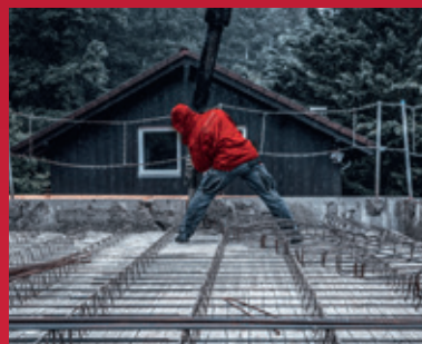
5. Betonage der Kelleraußenwände und -decke
