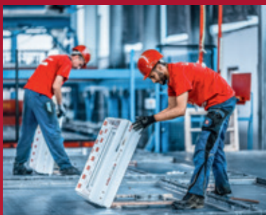
1. Einlegen der Einbauteile (Fenster, usw.) auf dem Schalungstisch
