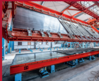
5. Verbinden von Innen- und Außenschale der Elementwand
