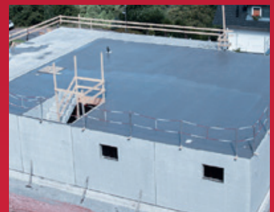
6. Fertig! Der frisch betonierte Glatthaar Keller
