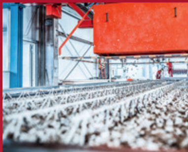
4. Automatisches Betonieren der jeweiligen Elementwandschale
