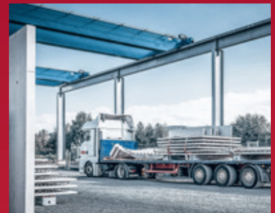
6. Verladung der fertig betonierten und ausgetrockneten Elementwand
