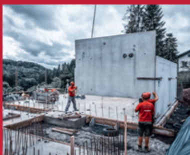
1. Versetzen der Kelleraußenwände
